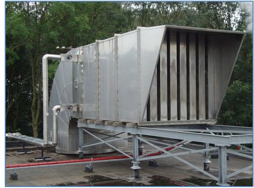
Figuur 5 De TAP en de ingebouwde rookgaswarmtewisselaar (3m x 3m) bij SKSB
